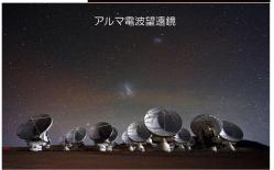
アルマ電波望遠鏡: 南米チリの標高 5,000m の高地に建設され、2011 年に科学観測を開始した巨大望遠鏡(12m 径のパラボラアンテナ 54 台と、7m 径のパラボラアンテナ 12 台、合計 66 台を結合させた、巨大な電波望遠鏡)。 これを使えば、星や惑星の材料となる塵やガス、生命の材料になるかもしれない物質が放つかすかな電波を、「視力 6000」に相当する圧倒的な性能でとらえることができます。 惑星誕生のメカニズムや地球外生命の可能性を明らかにし、私たちのルーツを宇宙にたどること。 これが、日本を含む 22 の国と地域が協力して運用するアルマ望遠鏡の使命です。
